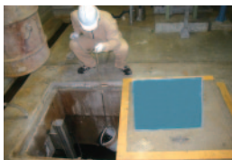
腐食環境検査
