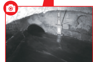
マンホール内増水時
