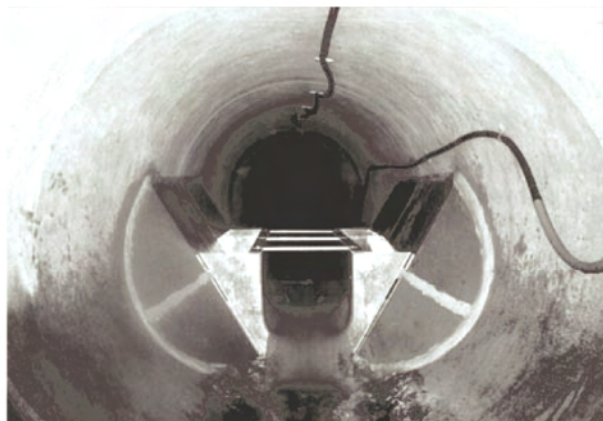
組立挿入型に標準型を仮設 (親子フリューム)
