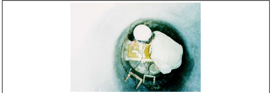
▼図 17.2 センサ・ロガーの設置
