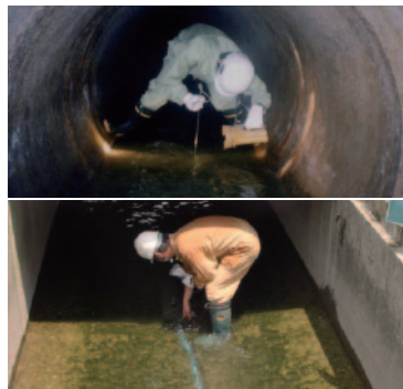
現場校正作業
