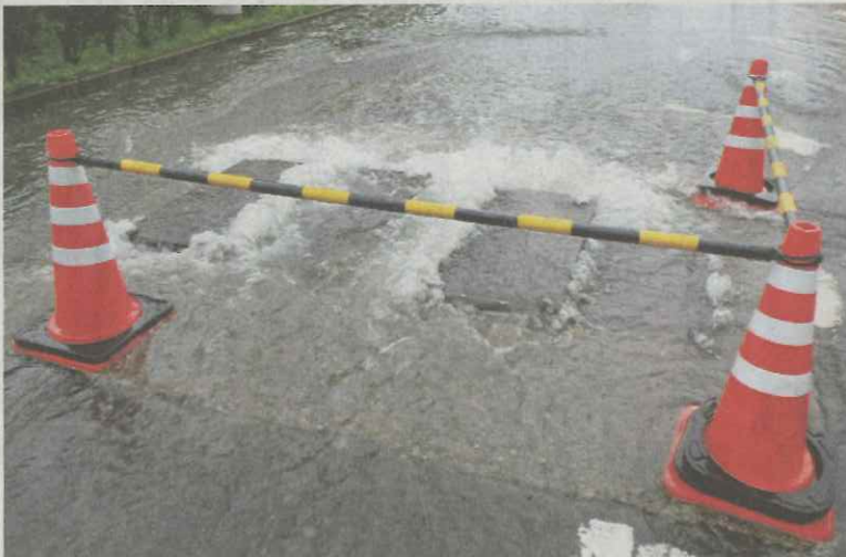
降雨時に発生する不明水で、マンホールから水があふれる被害などが発生している(昨年10月、仙台市)
