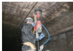
コア抜き調査
