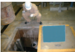
腐食環境検査
